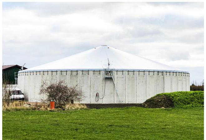
*Gasdichte Abdeckung von Güllebehältern*
