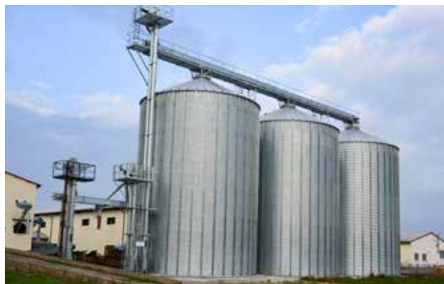
Elevatoren und Belüftungsanlagen im Energiecheck
