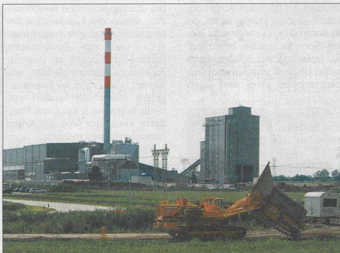
Das Industriegebiet um Osterweddingen wächst. Neben dem Flachglaswerk wurde kürzlich eine Produktionsanlage für Solarmodule eingeweiht.
