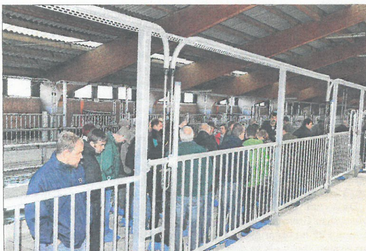
Der Milchviehlaufstall der Agrar-Gesellschaft in Klein Rottmersleben wurde zum Maststall umgebaut. Dazu wurde das Gebäude vollständig entkernt. Die Liegeflächen sind als Tretnistvariante ausgelegt, die Fressplätze wurden mit Teilspaltenboden und Unterflur-Schiebeentmischung versehen.
