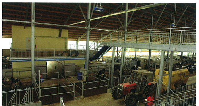
Blick auf Büro und Brücke (zentral im Stall)
